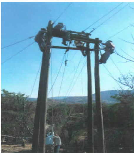
Tulumajillo (Cambio de Estructuras)
