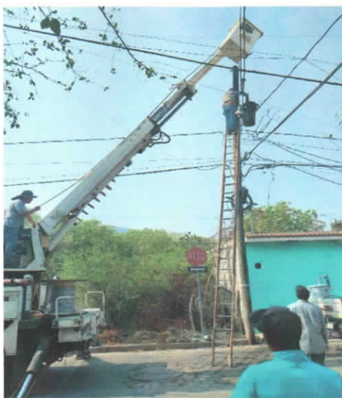
Colonia Hichos (Cambio de Transformador)
