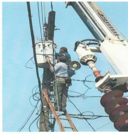
Colonia Hichos (Colocación de Transformador)
