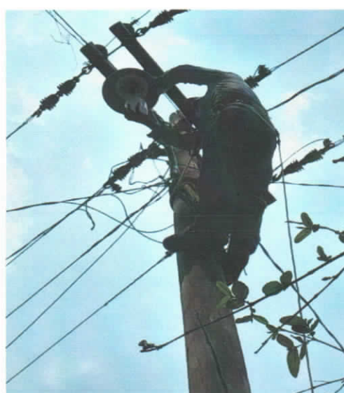
Barrio El Golfo (Colocación de lámpara)
