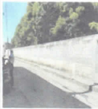
Fotografía: muro perimetral Fuente: propia
